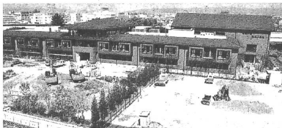
学校法人「森友学園」が小学校を建設しようとしていた工事現場＝大阪府豊中市
