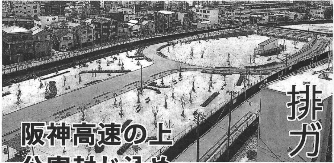
開園した正蓮寺川公園＝大阪市此花区
